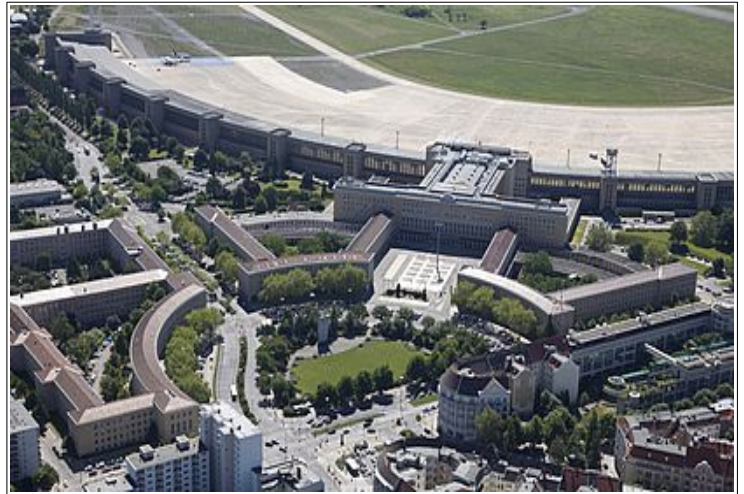
Blick über Platz der Luftbrücke auf Gebäudekomplex des THF Quelle: https://www.thf-berlin.de/standort
